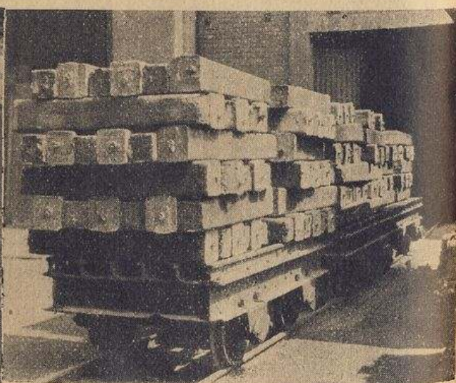
Doprava ocelových tyčí do válcovny.
