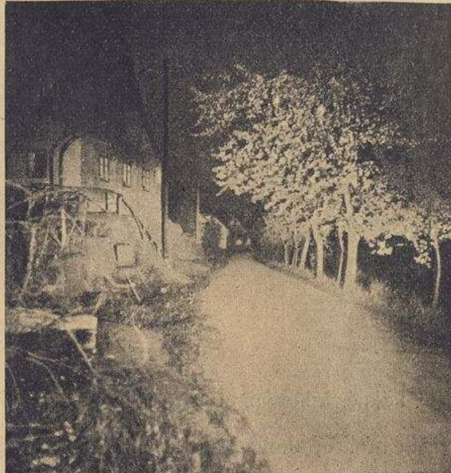
Osvětlení s Assmannovým sklem proti mlze: Neoslňující světlo s rozptylem do stran 15 m a zvýšený dosah světla.
